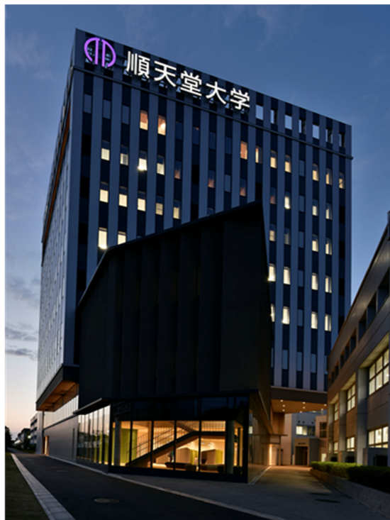
新講義棟（3号館）
