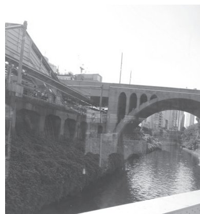
写真2. 地下鉄丸の内線から聖橋方面 H24.9.11
